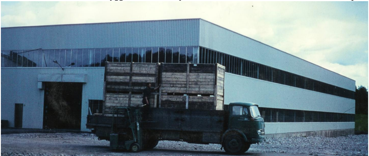
Bilde 31. Bildet viser første byggetrinn av den nye fabrikk til Jens A. Schou Mek. Verksted på
